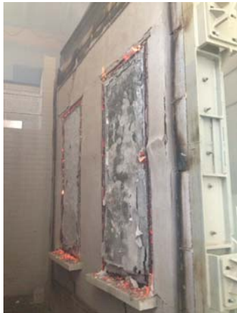
- Detalle de muestra después de ensayo. Cara no expuesta -
