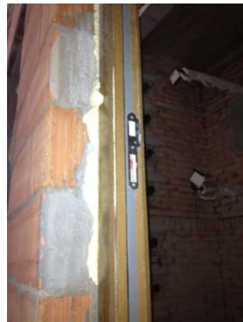
- Detalle colocación en obra soporte -
